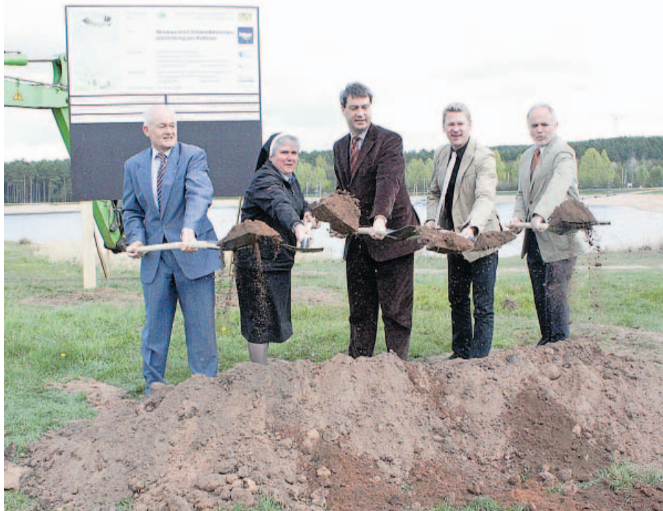
Beim Spatenstich für die Umwelteinrichtung am Rothsee griff gestern auch Umweltminister Markus Söder (M.) zur Schaufel. Foto: Amelie Strauß
